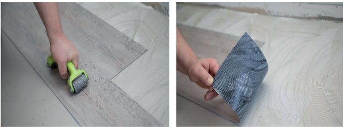
Markieren sie nun das einzusetzende Element und schneiden dieses passgenau so zu, dass die Randfugen offenbleiben, um Schallbrücken und Stauchungen an Wänden und Türzargen zu vermeiden.
